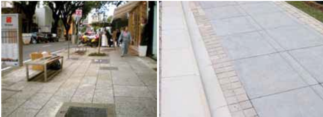
20. Passeio em placas pré-moldadas de concreto
