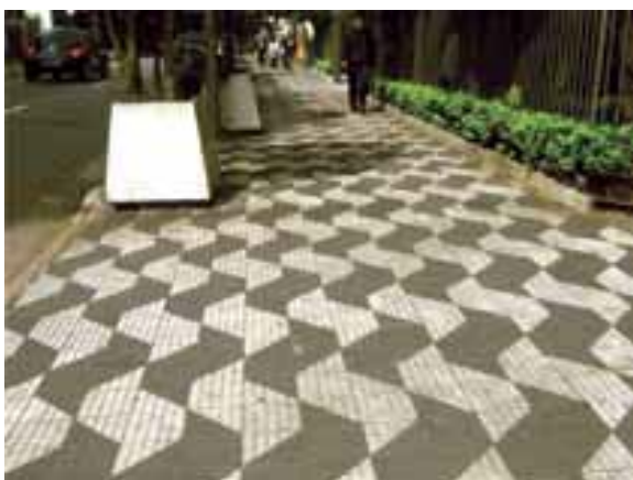
21. Passeio em ladrilho hidráulico.
