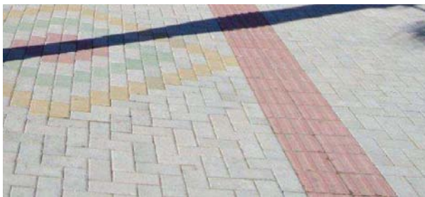
19. Passeio em bloco de concreto intertravado.
