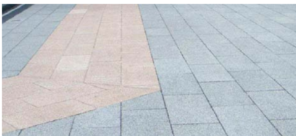
23. Passeio em placas de concreto drenante.
