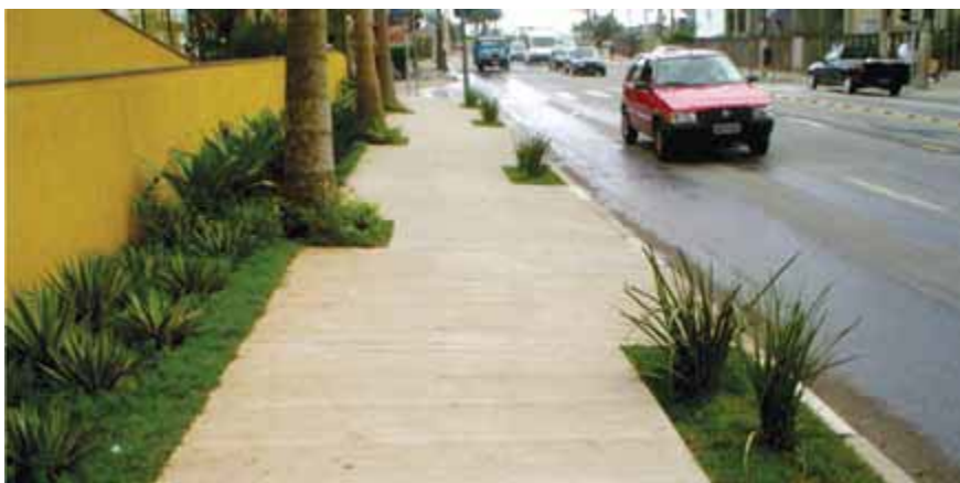
22. Passeio em concreto moldado in loco.
